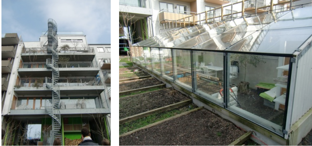
Bild 10 & 11. Det utanpå-liggande trapphuset & det gemensamma växthuset
