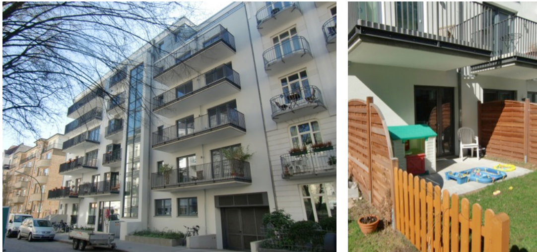
Bild 4 & 5. Fasad mot gatan & den gemensamma lekplatsen på baksidan
